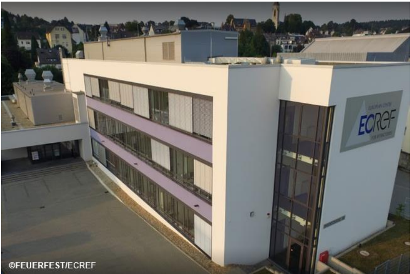
Bild 1: Das „European Centre for Refractories“ in Höhr-Grenzhausen
